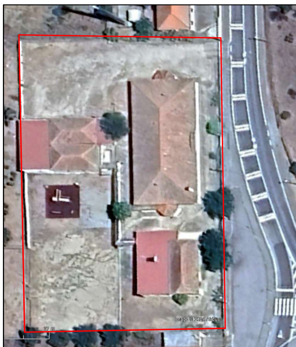
Localização de Escola Básica de Zebreira, Idanha-a-Nova, no aglomerado urbano de Zebreira
